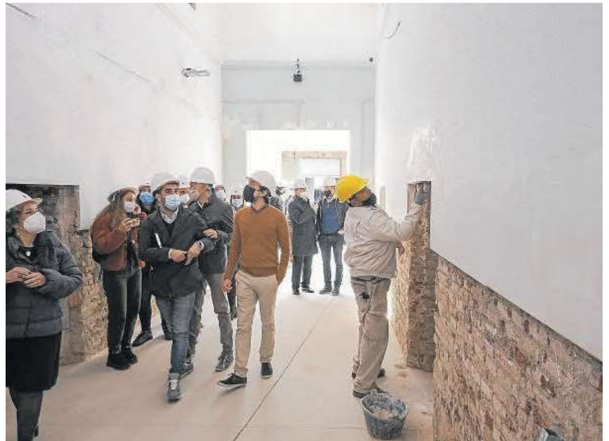
Un operario trabajando en el interior del Centre Social El Roser el día que se visitó su interior, este mes de marzo.
